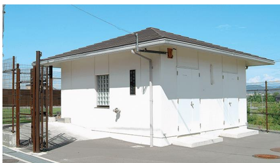
泉ヶ丘第1配水場
