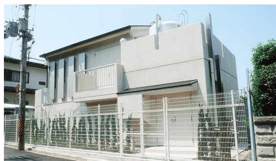
泉ヶ丘第2配水場
