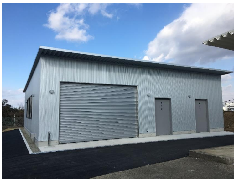
メーター倉庫
