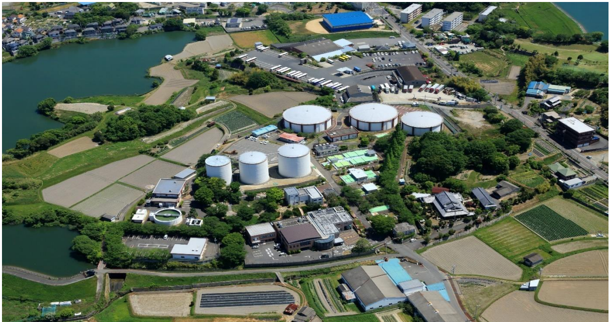
日根野浄水場の全景
